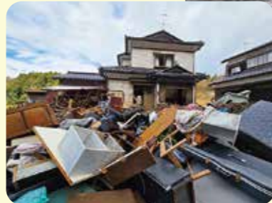
いまなお解体撤去は終わっていない
